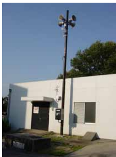
半固定型無線局全景
