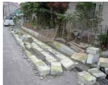
倒壊した石塀
