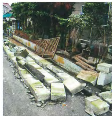
転倒した石塀 写真:東日本大震災(2011.3.11)の被害の様子
