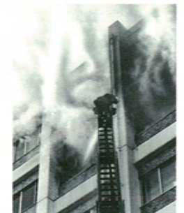
1978年宮城県沖地震による東北大学理学部化学棟の火災 (河北新報社提供)
